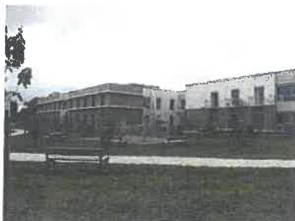
2. Vue depuis l'espace vert
